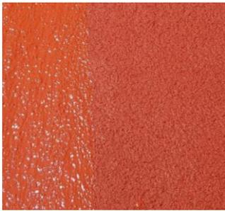
**Primera fase** limpieza de soporte mediante medios mecánicos y aplicación de capa de imprimación XECCOPRIMER® mediante proyección o sistema de rodillo tradicional. 0,250-0,300kg/m<sup>2</sup>
