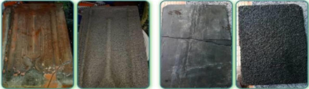
Producto líquido que se adapta a cualquier forma de cubierta sin necesidad de manejar rollos pesados de membranas en zonas con riesgo de caídas de altura.
